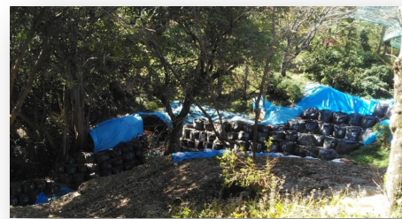
吾妻山山頂付近の崩落現場
